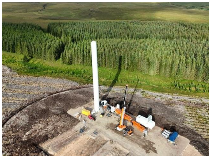
Montage d'éolienne parc Limekiln en Écosse
