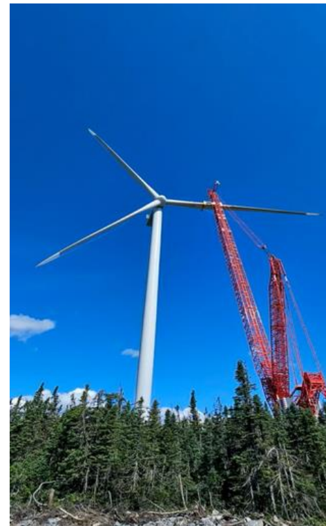
Montage d'éolienne parc Apuiat au Québec
